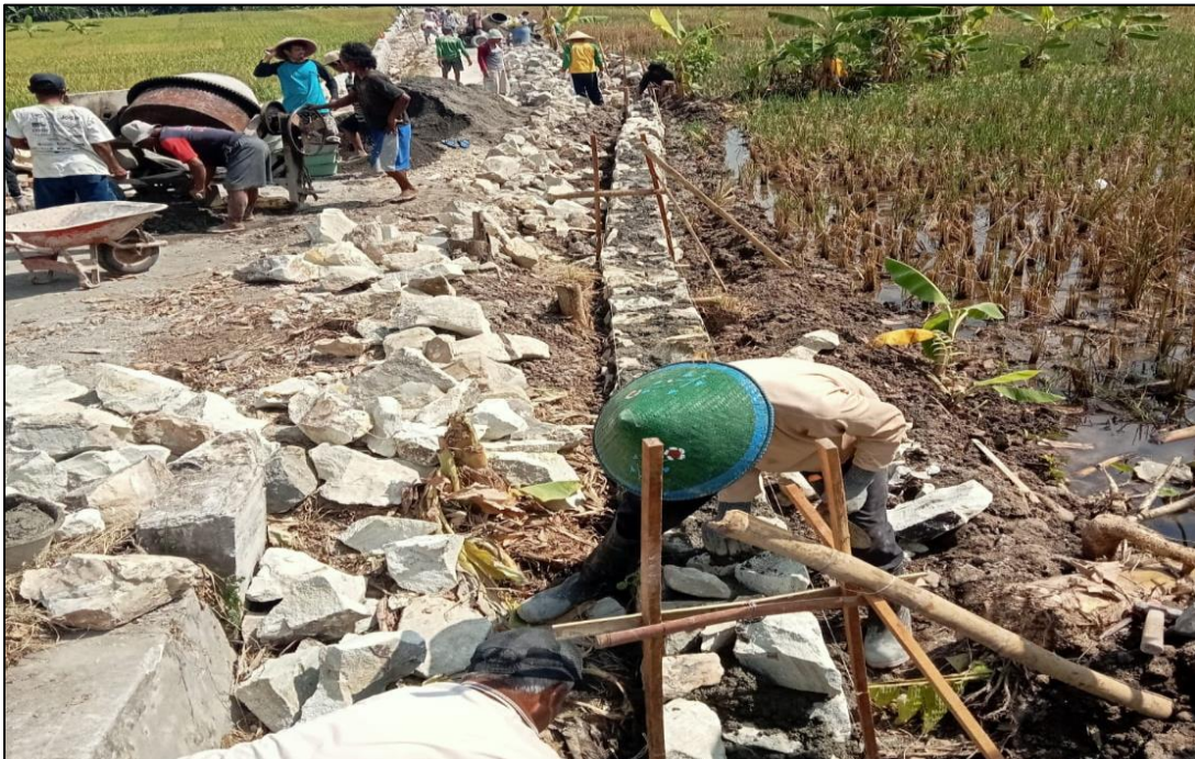
Gambar 63 Padat Karya Infrastruktur Pekerjaan Talud
